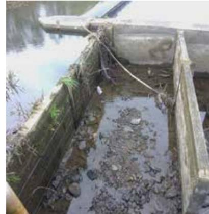
Verschlossener Fischaufstieg an der Freiburger Mulde (Frühjahr): Hier wird bei der Stromproduktion aktiv und umweltfreundlich CO2 eingespart. Eigentlich müsste an der betonierte Seite vom Wehr der Schlitzpass geöffnet sein und die Fischaufstiegsanlage mit Wasser durchströmen.
